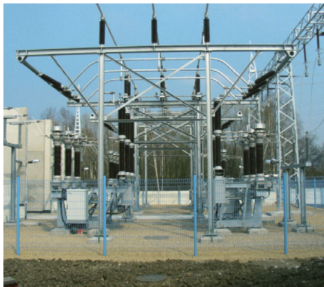
Figura 3.1-28: Arreglo H con SIMOVER, 145 kV, República Checa
