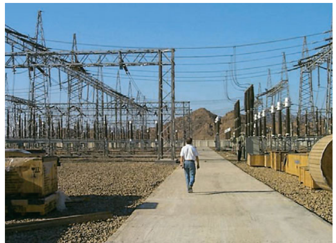
Figura 3.1-18: Disposición de torre central/centro, 220 kV, Egipto
