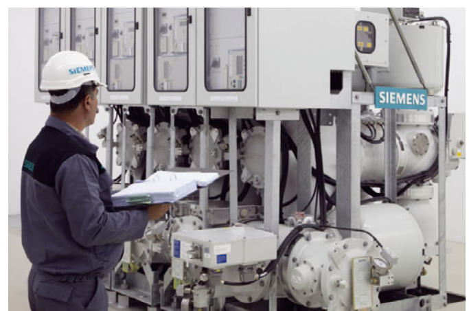
Figura 3.1-32: 8DN8 GIS para 72,5 kV, disposición de barra colectora única
